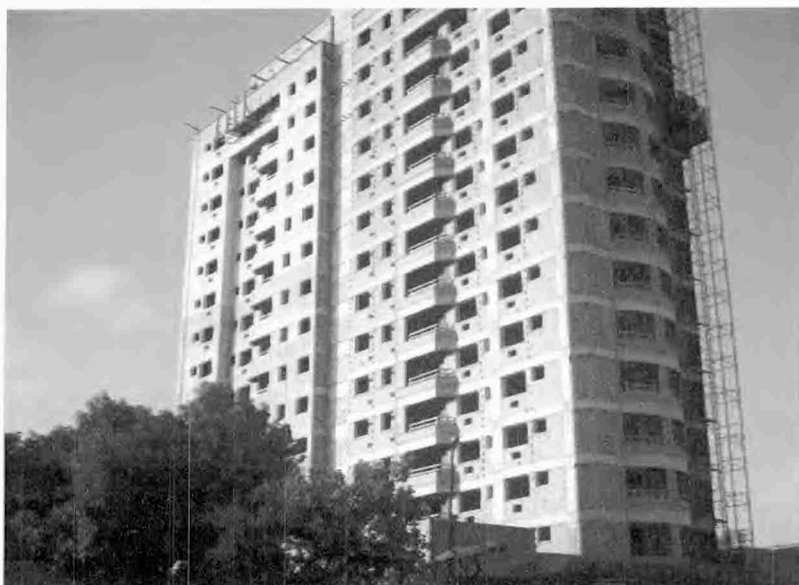
FOTO 6 -Prédio em construção na Rua Santos Saraiva, ano de 2006.
