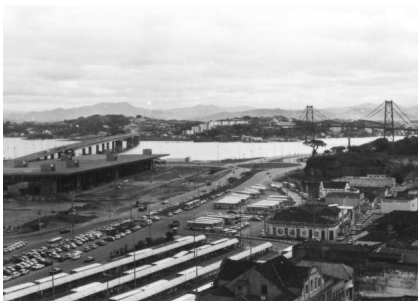
Figura 30: Vista parcial da ponte Colombo Salles e do Terminal Rita Maria, inaugurado em 1981.
