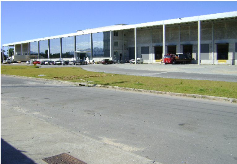
Figura 9 – Centro de distribuição da Midea Fonte: arquivo do autor, 2009.
