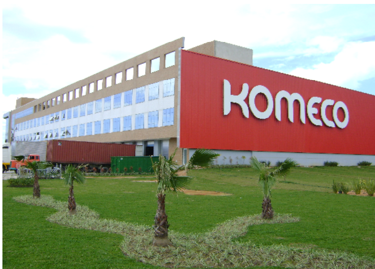
Figura 18 – Indústria de ar condicionado Fonte: Arquivo do autor, 2010.
