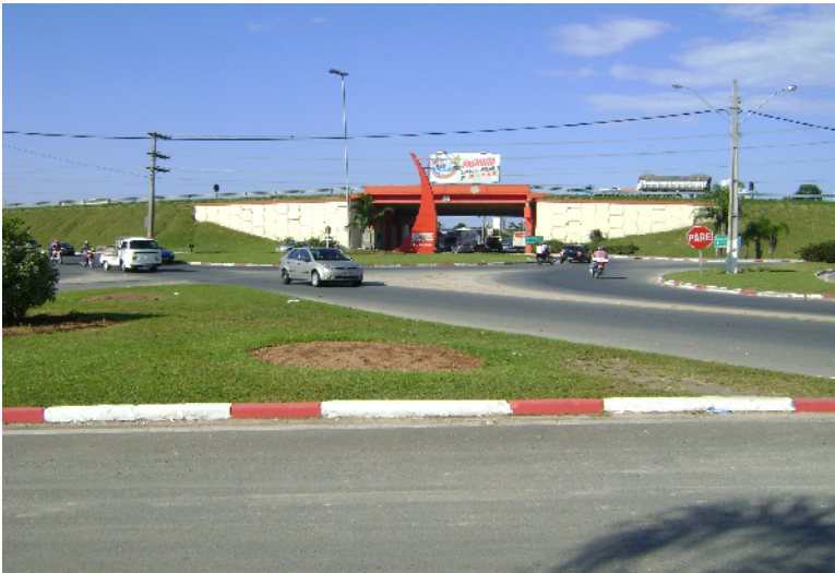
Figura 24 – Viaduto e túnel entre a BR-101 e BR – 282, Bela Vista Fonte: Arquivo do autor, 2009.
