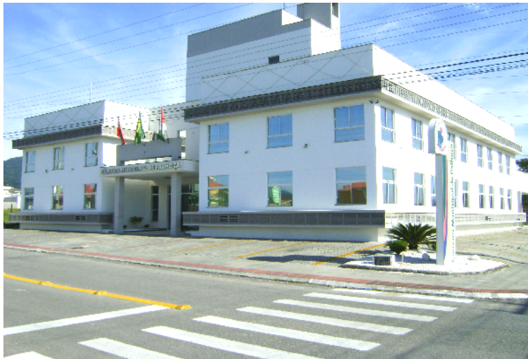
Figura 27 – Novo prédio da Câmara de Vereadores, no loteamento Pagani Fonte: Arquivo do autor, 2010.
