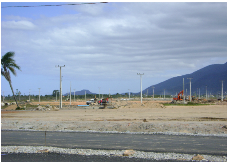
Figura 21 – Obras de infra-estrutura do loteamento Nova Palhoça Fonte: Arquivo do autor, 2010
