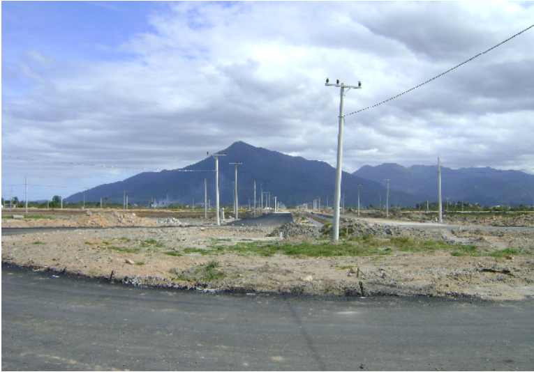
Figura 22– Vista parcial das obras do loteamento Nova Palhoça Fonte: Arquivo do autor, 2010.
