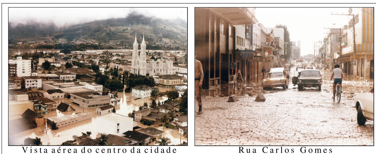
Figura 17: Imagens das enchentes ocorridas na década de 1980
